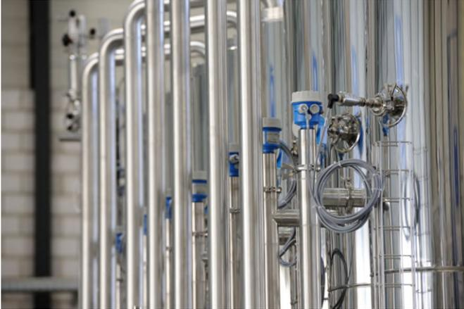
Debido a su principio de funcionamiento capacitivo, es posible elegir dispositivos para medir en rangos muy pequeños, con la barra que varía de 100 mm a 4000 mm, estando totalmente revestidos de PTFE o PFA, lo que garantiza al equipo una buena resistencia a la corrosión en medios agresivos.
